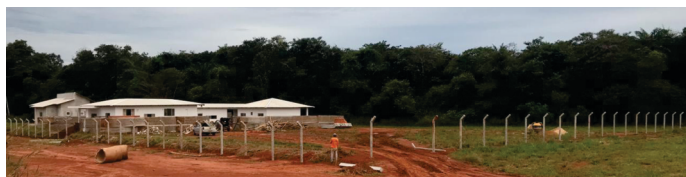
CONSTRUÇÃO DO PRIMEIRO CETRA EM LUCAS DO RIO VERDE/MT
