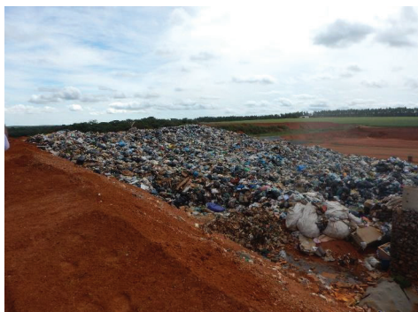
Figura 36. (A) Maciço em uso com compactação dos resíduos; (B) Dreno de gases (PMSB-MT, 2016)
