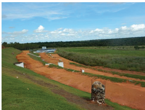
Figura 36. (A) Maciço em uso com compactação dos resíduos; (B) Dreno de gases (PMSB-MT, 2016)
