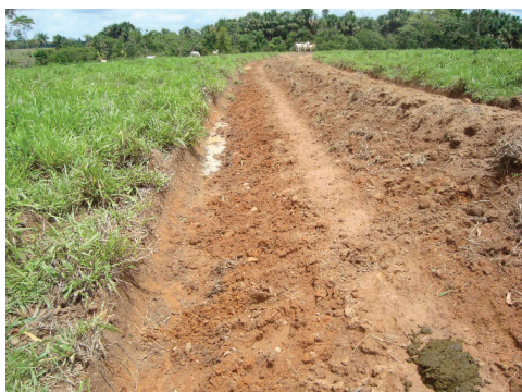
Figura 43. Terracamento construído em Alta Floresta-MT.
