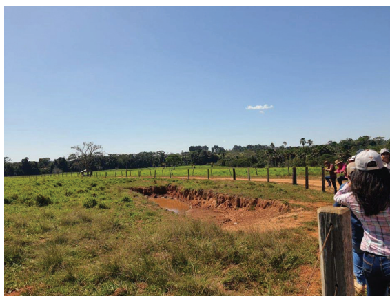
Figura 45. Barraginha construída em Alta Floresta-MT.
